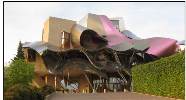
Bodega und Hotel Riscal
